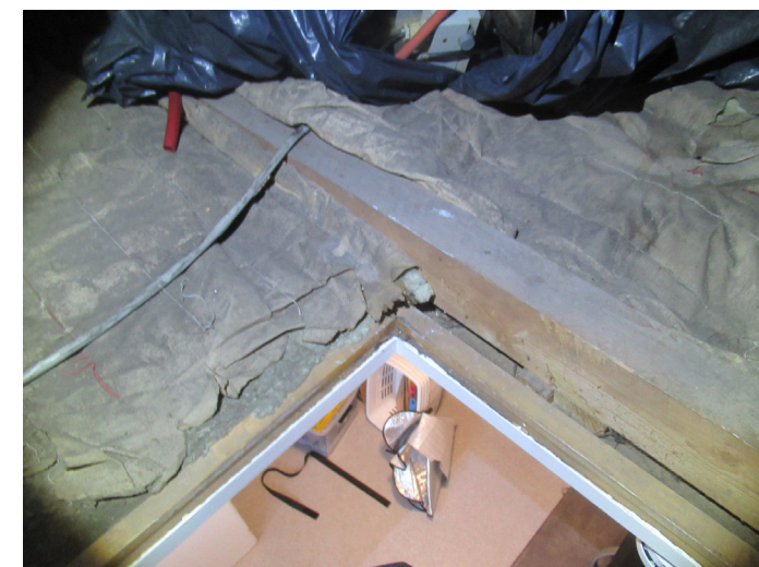
Eksempel på loftslem uden isolering.
