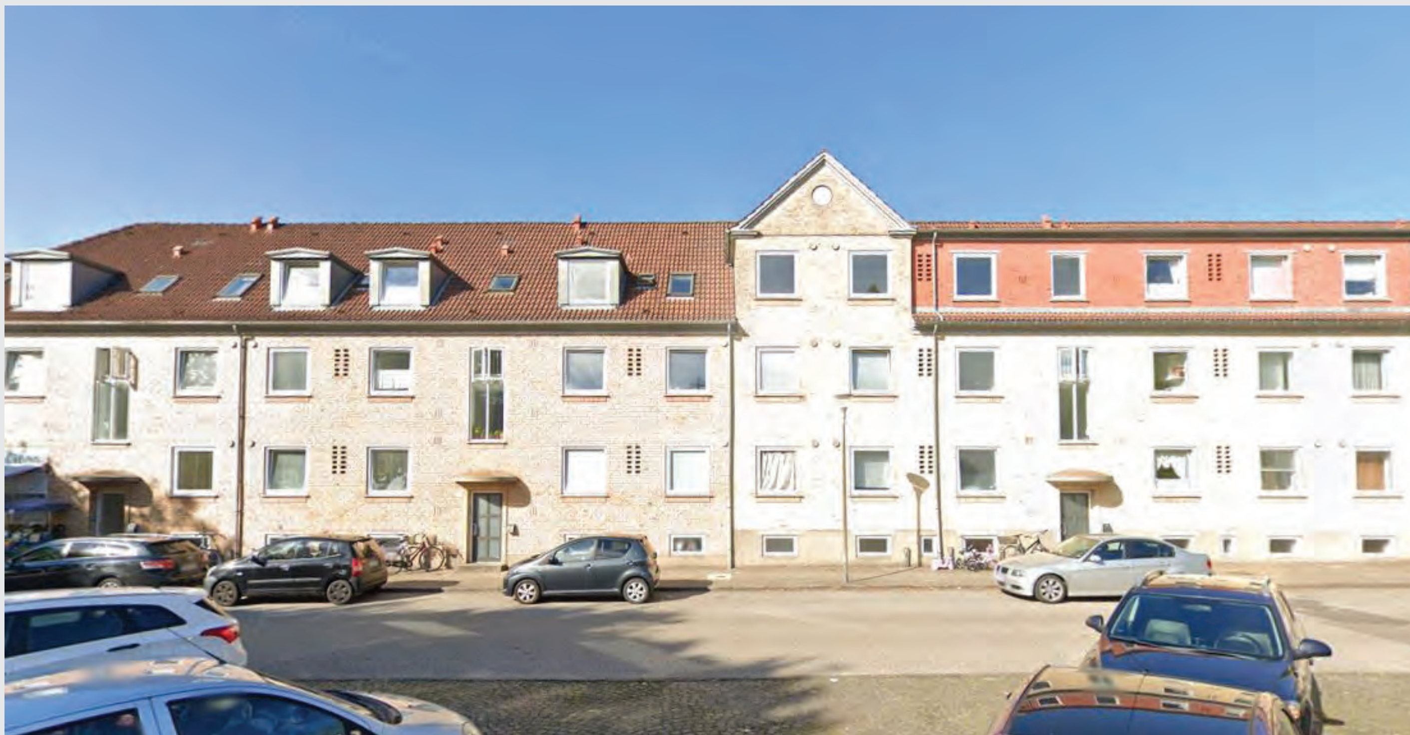
BLOK B - FØR BILLEDE MURSTENSFACADE MED FLOTTE DETALJER
