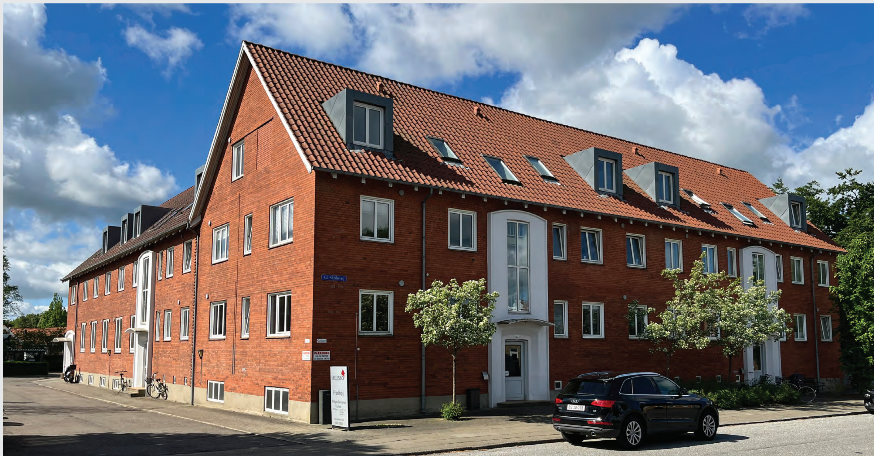
BLOK P - FØR BILLEDE MURSTENSFACADE MED FLOTTE DETALJER
