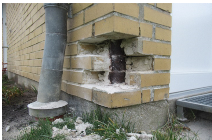
Eksempel på rusten - bærende stålsøjle.
