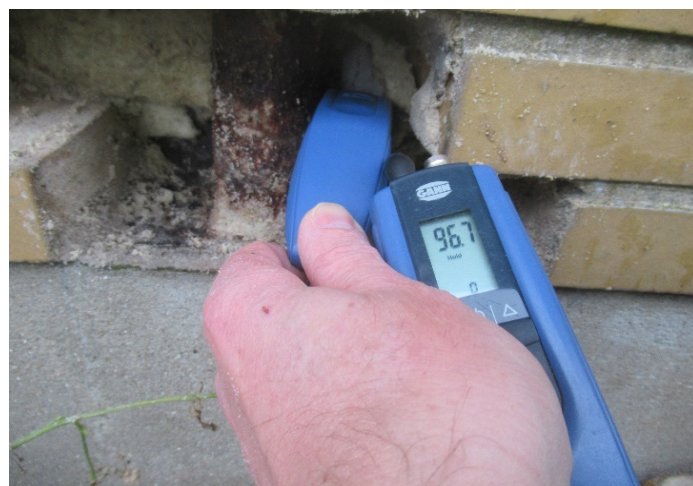
Eksempel på fugtmåling i bagmur.
