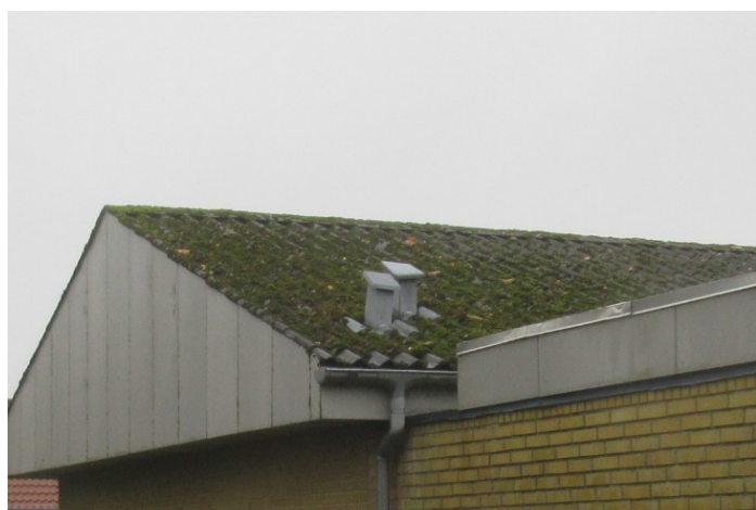
Eksempel på mosbegroning på tagflade.
