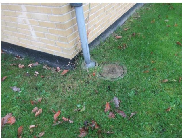
Eksempel på oprindelig rensbrønd ved tagned- løb ved nr. 21.
