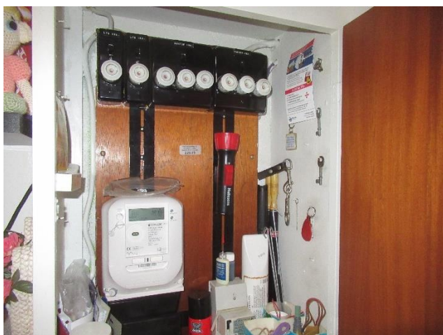
Eksempel på HFI-afbrydere og målere i nr. 16. Eksempel på afbryder i nr. 21.
