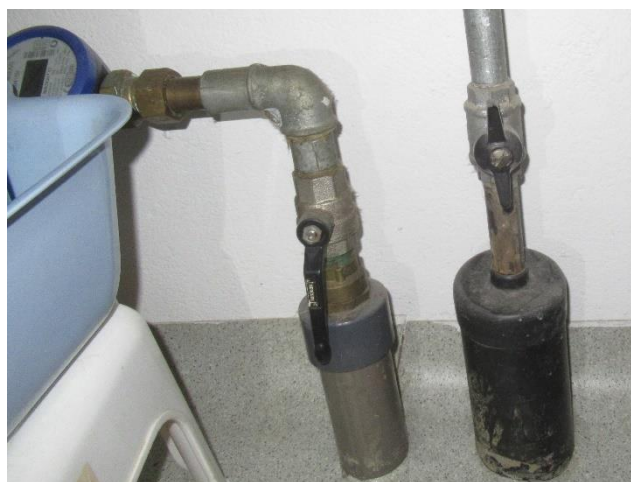
Eksempel på vandstik i bryggers nr. 21.
