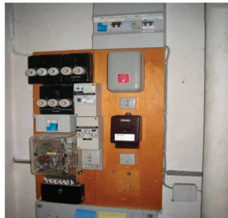
Hovedfordelingstavle i anden teknikrum i kælder
