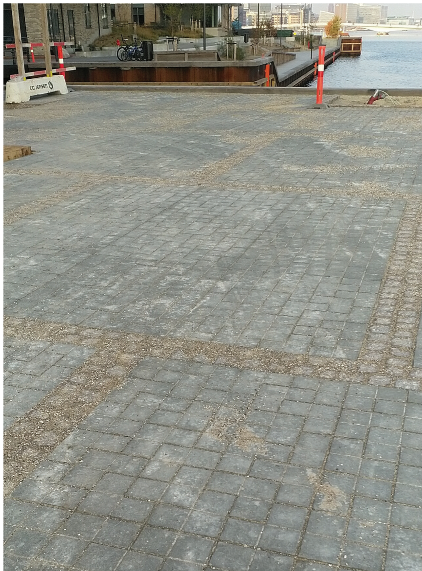
Betonstens belægning på vej- og manøvrearealer fx. coloc square (maskinudlægninglægning)
